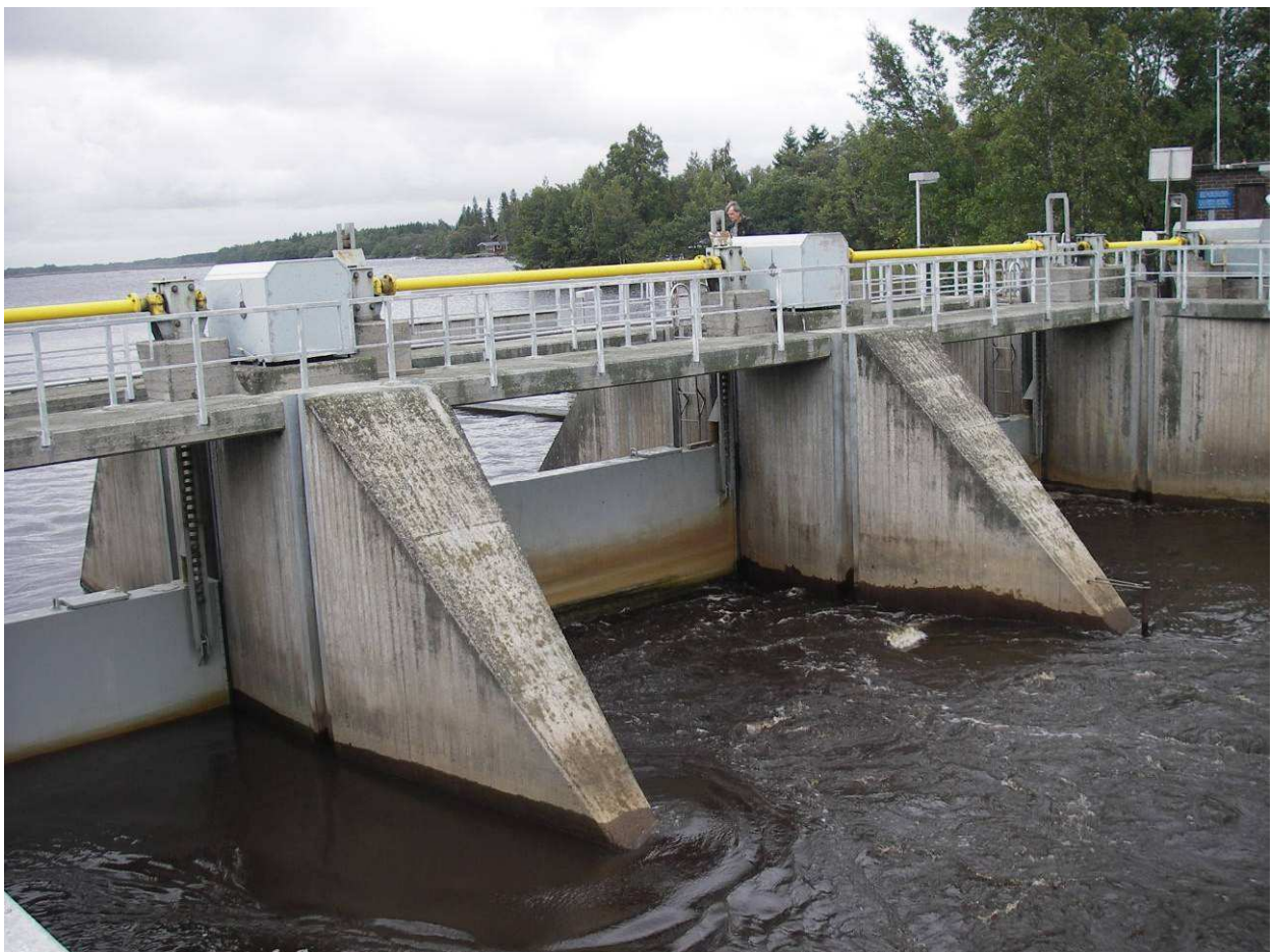
Bild 12. Dammkonstruktioner i Västerfjärdens bassäng. (Suvi Saarniaho 2009)
