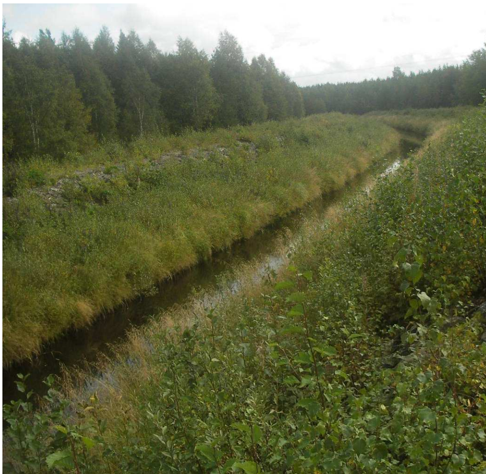
Bild 10. Kivi- och Levalampi påfyllningskanal vid Varainkoski där vattenlederna korsar varandra i olika plan. (Suvi Saarniaho 2009)
